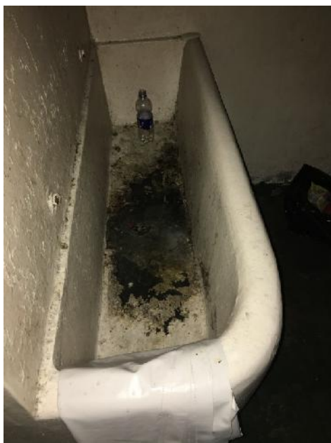
Bacha interior de la celda
