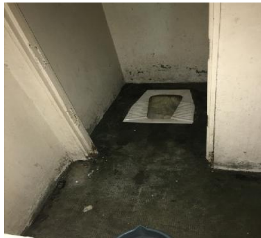
Letrina interior de celda
